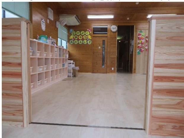
【玄関から見る床暖房】
